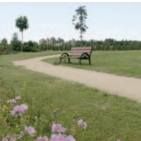
Duomix als fundering onder een halfverharding
