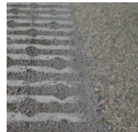
Duomix fundering onder grasbetonblokken
